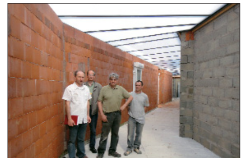
Visite du chantier le 26 Avril 2011.
